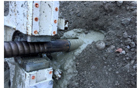
3. Verlängern des KÜPS® Beliebiges Verlängern und somit optimale Anpassung an die Geologien. Abkoppeln am Bohrhammer.
