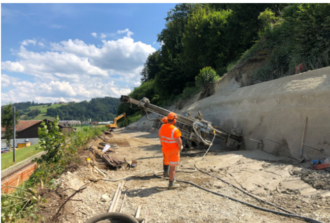
Nagelwand 32/60 in Gettnau (BLS), etwa 1000 Laufmeter
