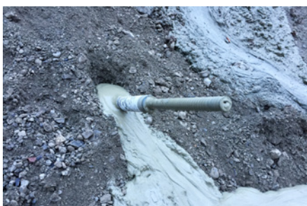
7. Komplett verpresstes und eingebettetes KÜPS® -System.
