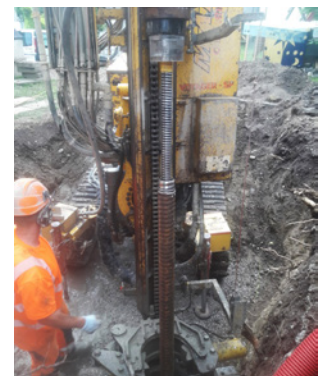
Mikropfähle 38/76 in Teufen, etwa 350 Laufmeter
