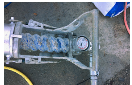
6. Überwachung des inneren Injektionsdrucks.
