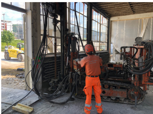
Mikropfähle 38/76 in Zug, etwa 500 Laufmeter
