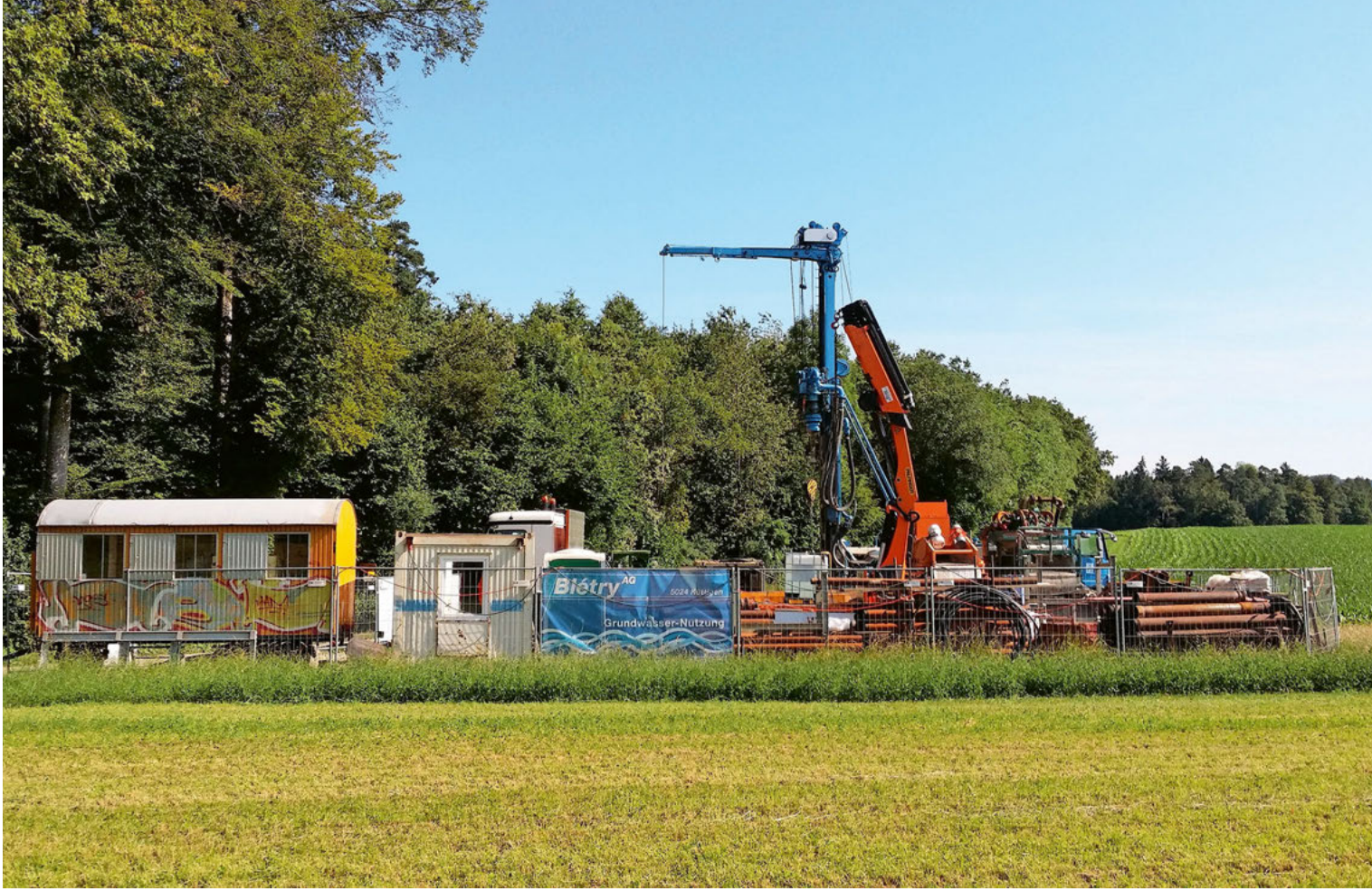
Die Bohrstelle westlich von Bülach/ZH.
