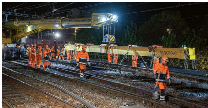
Beginn der Bauarbeiten des neuen Bahnhofs Europaplatz Nord.
