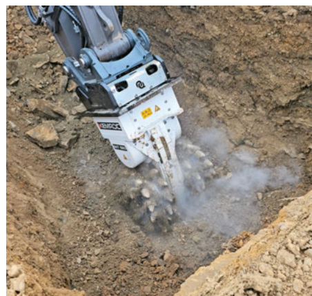
Die Querschneidkopfräse im Einsatz. Mit diesem Anbaugerät am Grossbagger wurden grosse Mengen an festem Dolomitgestein gelöst.
