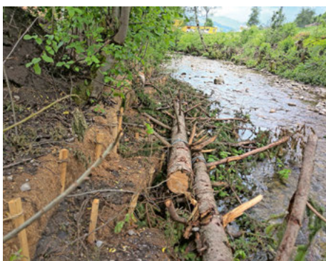
Situation beim Pilotprojekt Wattwil (links) kurz nach der Installation mit Raubbaum und Holzrolle-Faschinen am 23.05.2022 und rechts am 07.10.2024.
