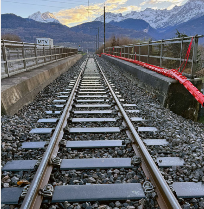
In St. Triphon wurden 200 Stück STRAILway Kunststoffschwellen mit eingefräster Direktbefestigung auf einer Brücke verbaut.
