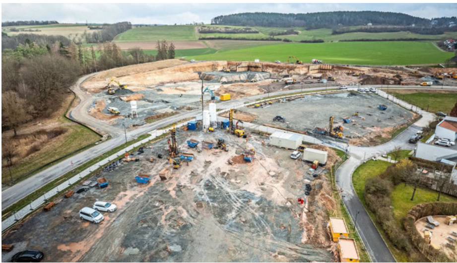
Das Erdwärmesondenfelder wurde in Rekordzeit erstellt. Schrittweise wurden die 128 Erdwärmesonden bis in 80 m Tiefe abgeteuft.
