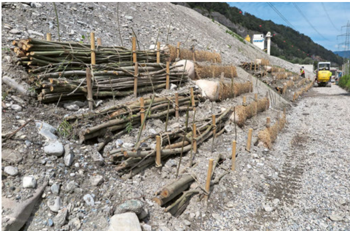
Grosslaborversuch Calanda (GR), Blickrichtung Nordost; links: eingebauten Faschinen (Aufnahme vom 05.08.2021); rechts: Entwicklung der Begrünung nach ca. drei Jahren. (Aufnahme vom 26.09.2024)
