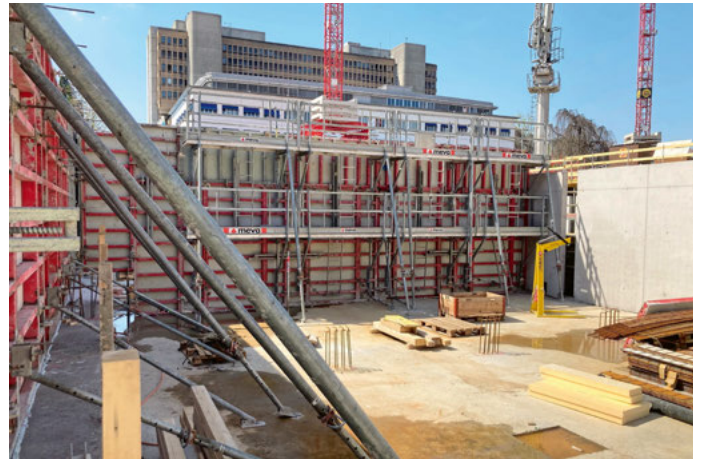
Die alkus AL20 kam unter anderem für den Bau der Wände, die Untergeschosse und den Sichtbeton in verschiedenen Gebäudebereichen zum Einsatz.
