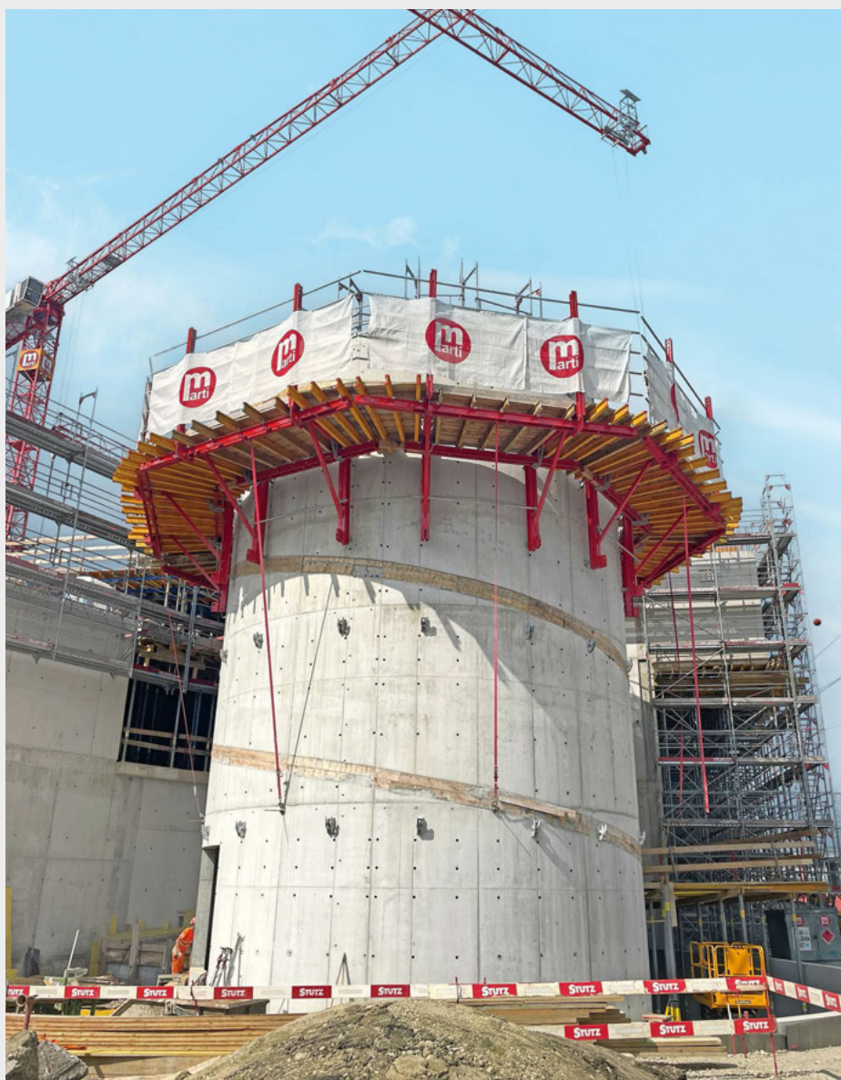
Einer der zwei Spindelkerne mit 10,40 m Durchmesser. Schlussendlich ein rundum gelungenes Projekt für die Marti AG und Meva.
