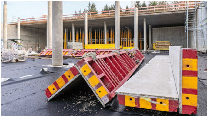
Bei allen trinkwasserberührenden Innenflächen wurde die Wandschalung nach jeder Betonage mit wasserabführenden Schalungsbahnen neu belegt.
