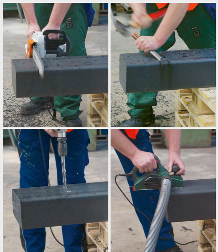
Die Bearbeitung der Kunststoffschwelle ist komplett unbedenklich, erfordert keine Spezialausrüstung und kann mit handelsüblichen Werkzeugen vorgenommen werden.
