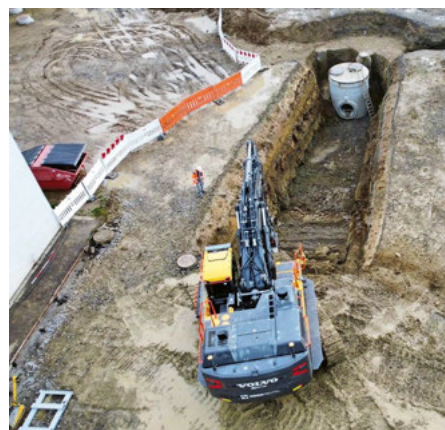
Hier entsteht eine neue Mehrzweckhalle. Für die Erdarbeiten wählte das Bau-Unternehmen einen 75-t-Bagger sowie einen 35-Tonner.
