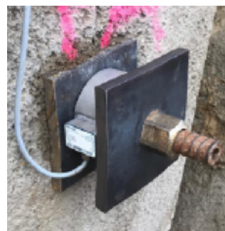
Einbau einer Kühler Kraftmessdose.
