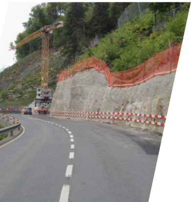
Stabilisation de routes
