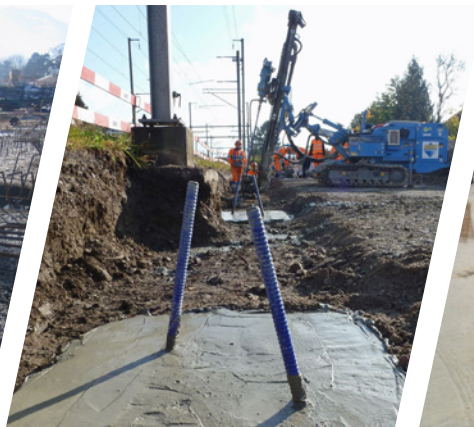
Consolidation de fondations
