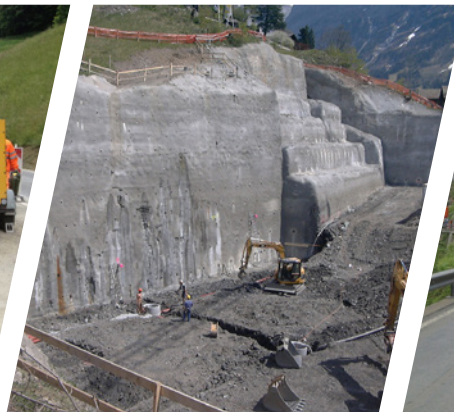
Protection des fouilles
