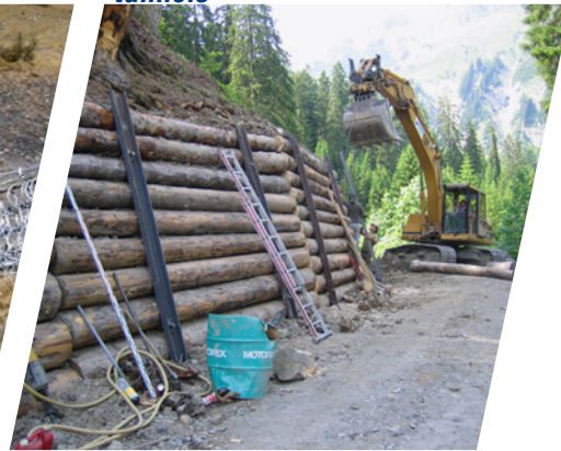
Stabilisation de routes
