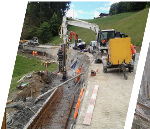
Stabilisation de tracé
