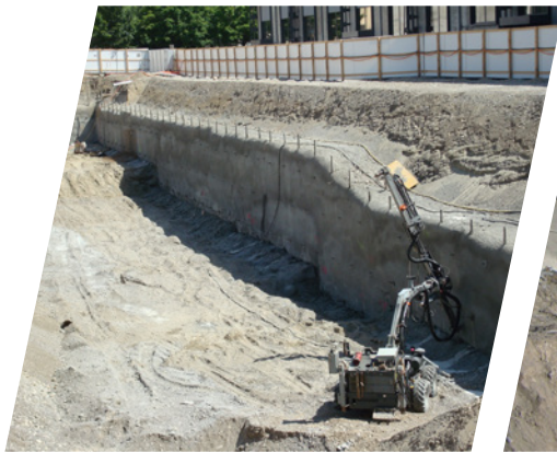
Parois de pieux ancrés
