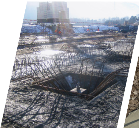
Fondation de pieux
