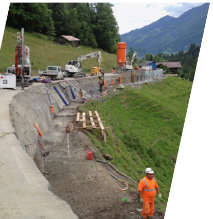
Stabilisation des routes et des tracés
