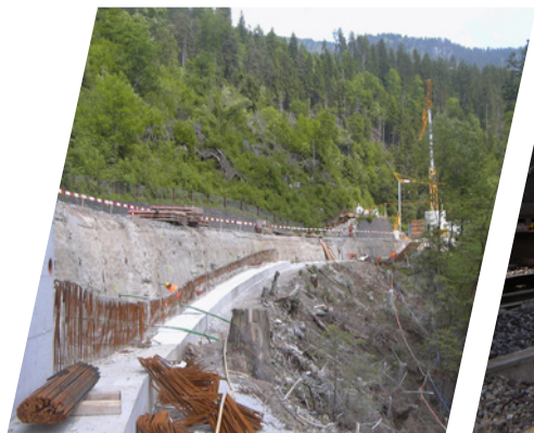
Stabilisation de routes
