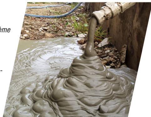
Nous proposons différents dispositifs d'injection. Lors de la première utilisation, l'exécution du mortier et du fabricant de machine est surveillée. Sur demande, nous contrôlons la force d'arrachement du tirant d'ancrage posé.
