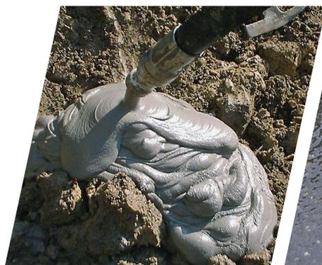
Remplissage avec mortier, ciment ou KÜMIX®
