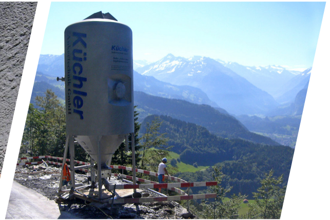
Remplir, malaxer et pomper le coulis d'injection
