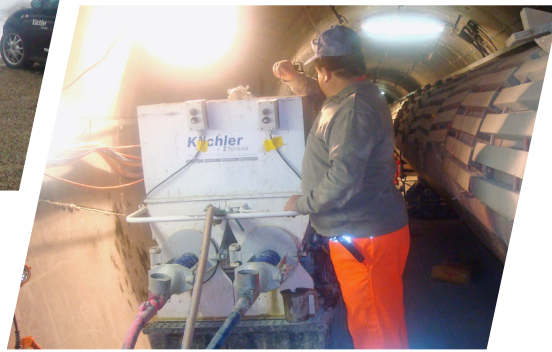
Construction de galerie avec installation extérieure, pompage sur 3 000 m
