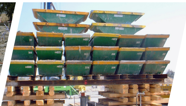
Essai de charge sous pression Sans post-injection max. 1 500 kN Avec post-injection K max. 3 000 kN
