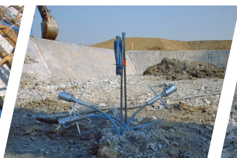
Raccords de post-injection K Pression d'éclatement env. 15–65 bars après 24 heures
