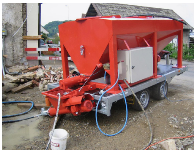
Verfüllung mit «Fräschu»-Siloanhänger
