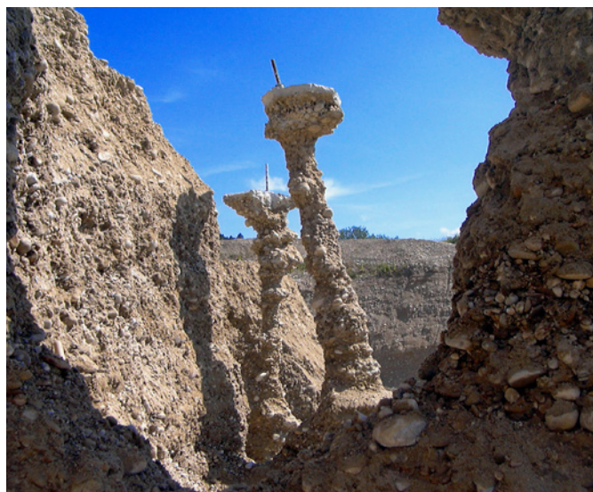
Einsatz von thixotropem Mörtel
