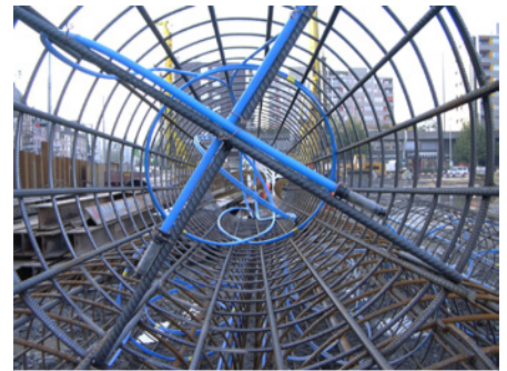
Nachinjektion Bohrpfähle
