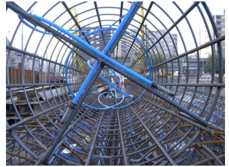
Nachinjektion Bohrpfähle
