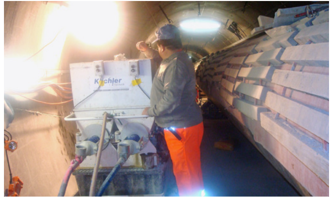
Stollenbau mit mengenregulierter Doppel-MUNGG-Pumpe
