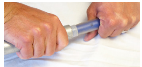
Fixieren des Ventils und Quetschhülse von Hand
