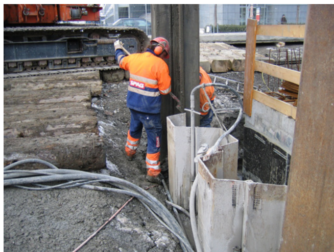
K Injekt 102 eignet sich auch zur Verfüllung beim Ziehen von Spundwänden
