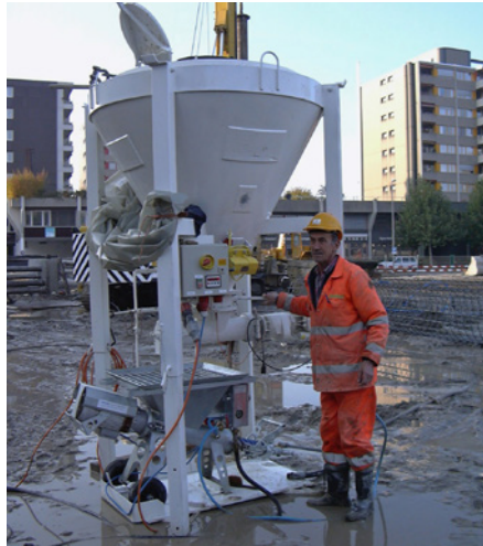
Injizieren mit Sackmaterial oder BIG BAG für kleinere Arbeiten
