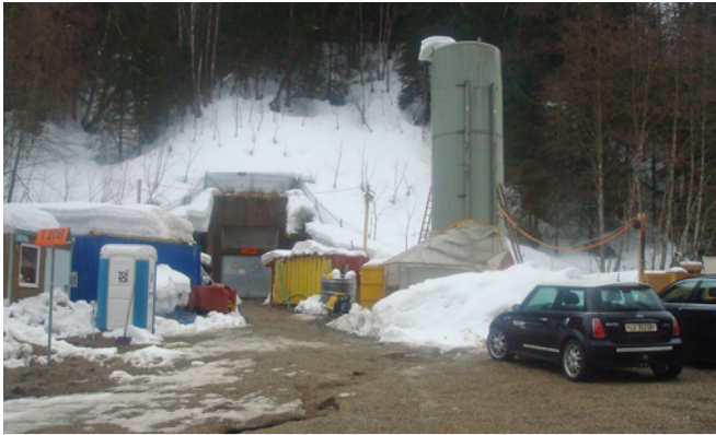
Stollenbau mit Ausseninstallation 3 000 m Pumpenleistung
