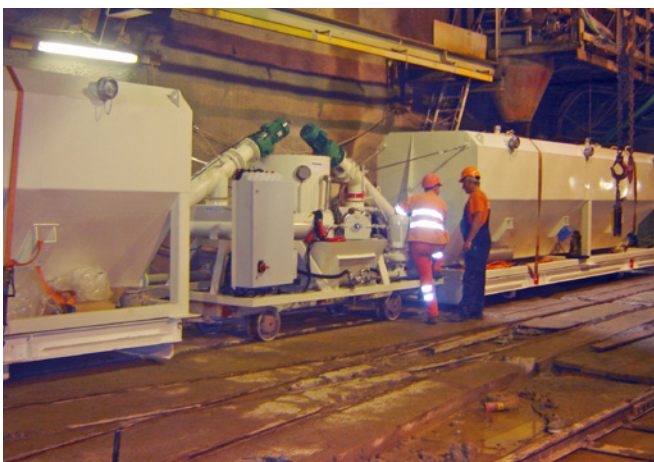
Tunnelbau mit Bahnsilo | 80 t Injektion auf 10 m 3 /h
