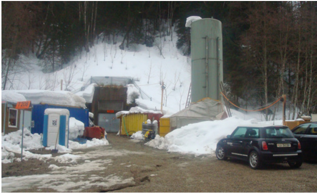
Stollenbau mit Ausseninstallation 3 000 m Pumpenleistung
