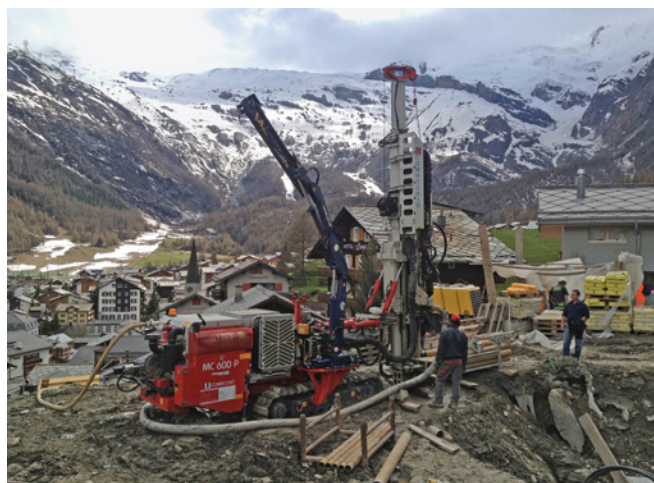
Hinterfüllung von Erdsonden
