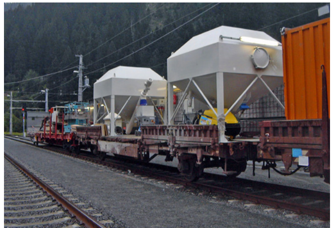
Tunnelbau mit Bahnsilo
