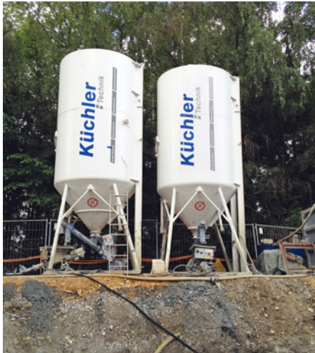
Automatisches Injizieren mit dem Küchler-System per Knopfdruck
