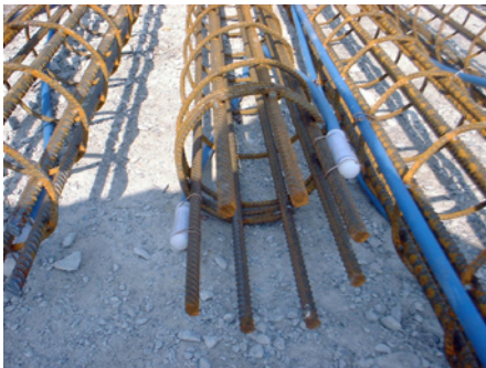
Befestigung von K Injektionsverpressleitungen
