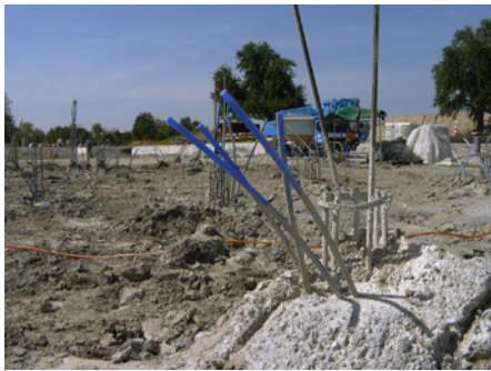
Oberbetonpfahl mit vier Stück K Injektionsleitungen in zwei verschiedenen Tiefen versetzt
