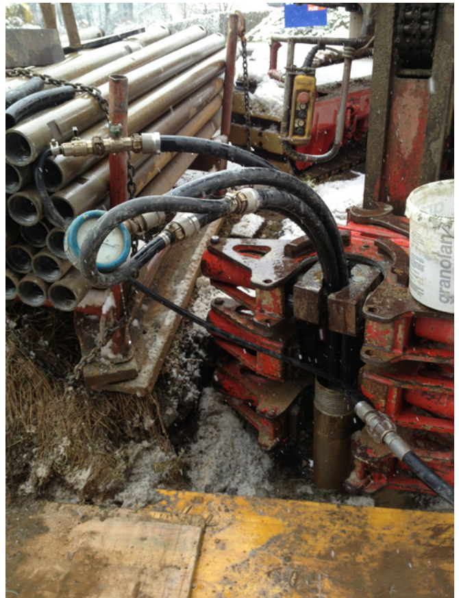
Im Bohrrohr eingebaute Sonden
