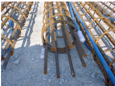
Befestigung von K Injektionsverpressleitungen
