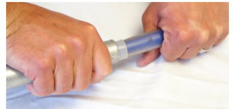
Fixieren des Ventils und Quetschhülse von Hand
