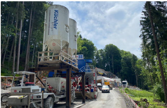
Tunnelbau mit Silo-Ausseninstallation
