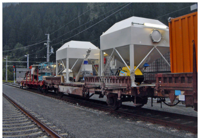
Tunnelbau mit Bahnsilo
