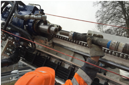
1. KÜPS® ankoppeln am Bohrhammer.
