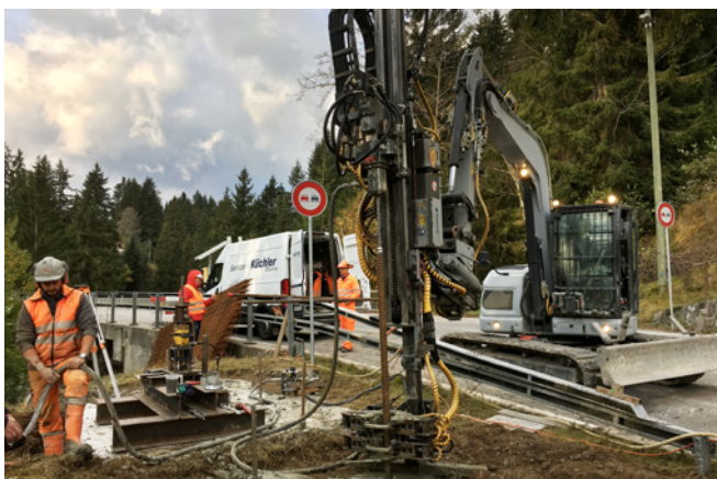
Probebohrungen in Zweisimmen, Berner Oberland
