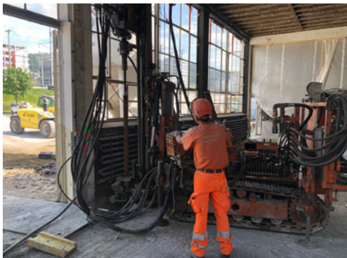
Mikropfähle 38/76 in Zug, etwa 500 Laufmeter
