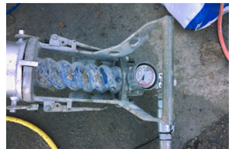
6. Überwachung des inneren Injektionsdrucks.
