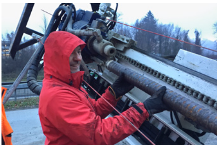
4. Verlängerung an dem gebohrten KÜPS® -Ende montieren. Anschliessend am Bohrhammer einschrauben, Injektion starten und weiterbohren bis die Bohrtiefe wieder erreicht ist.
