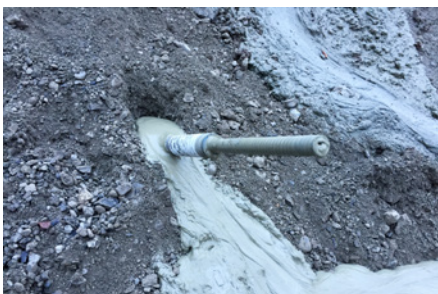
7. Komplet verpresstes und eingebettetes KÜPS® -System.
