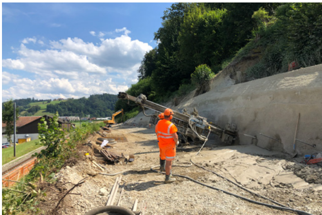
Nagelwand 32/60 in Gettnau (BLS), etwa 1000 Laufmeter
