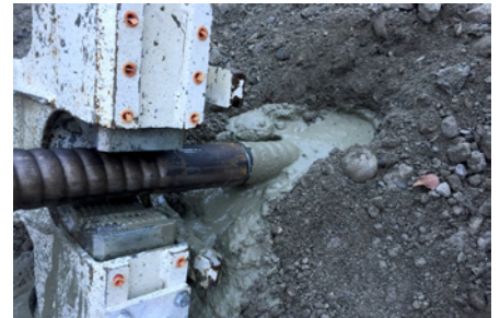
3. Verlängern des KÜPS® Beliebiges Verlängern und somit optimale Anpassung an die Geologie. Abkoppeln am Bohrhammer.
