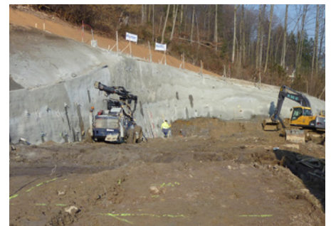
Baugrubensicherung
