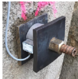
Einbau einer Kühler Kraftmessdose.
