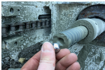
5. Erreichen der Verankerungslänge. Abkoppeln am Bohrhammer, Dämpfungsschlagadapter entfernen, Abpressadapter montieren, Kugel in die KSB® Ankerstange einführen und mittels KÜMIX® den inneren Ringraum über das Injektionsventil bei der Bohrkronen injizieren. Beim Austritt des Abpressadapters wird der Ausgang mittels Kugelhahnen geschlossen und der innere Ringraum, mit 2 Bar, auf Dichtigkeit überprüft.
