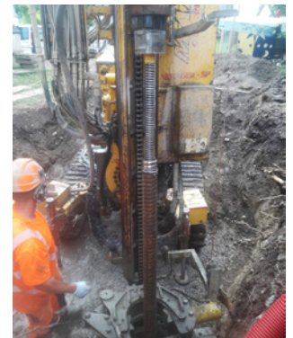
Mikropfähle 38/76 in Teufen, etwa 350 Laufmeter
