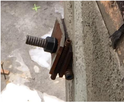
Durchbiegen der Ankerplatte Gefährliches Schiften
