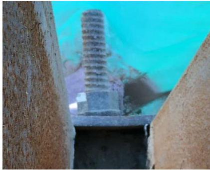
Winkel ohne Winkelscheibe Durchbiegen der Ankerplatte
