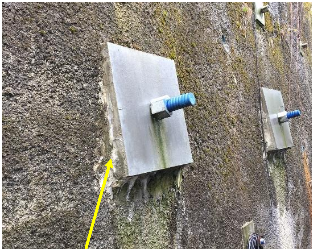
Anker mit Mörtelbett und KSB® Ankerplatte
