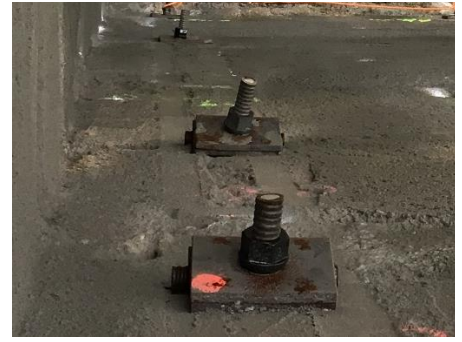
Anker zu wenig genau gebohrt Ankerkopf ohne Winkelscheibe
