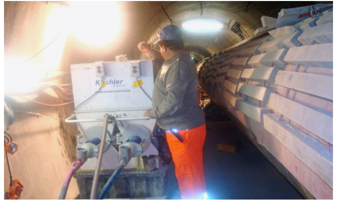
Stollenbau mit mengenregulierter Doppel-MUNGG-Pumpe
