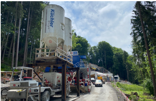
Tunnelbau mit Silo-Ausseninstallation
