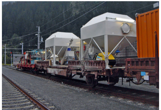
Tunnelbau mit Bahnsilo
