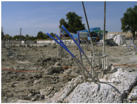
Oberbetonpfahl mit vier Stück K Injektionsleitungen in zwei verschiedenen Tiefen versetzt
