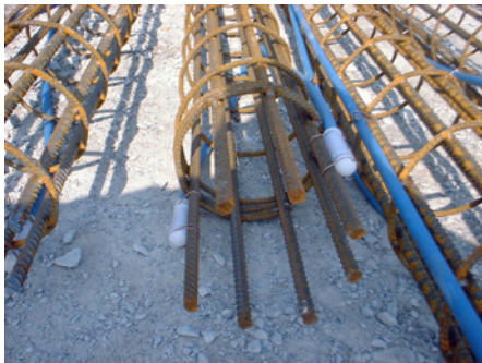
Befestigung von K Injektionsverpressleitungen
