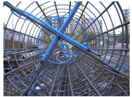
Nachinjektion Bohrpfähle
