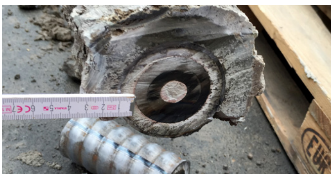
Erreichte innere und äussere Überdeckung.
