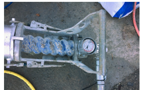
6. Überwachung des inneren Injektionsdrucks.
