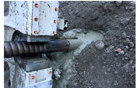
3. Verlängern des KÜPS® Beliebiges Verlängern und somit optimale Anpassung an die Geologien. Abkoppeln am Bohrhammer.
