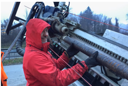
4. Verlängerung an dem gebohrten KÜPS® -Ende montieren. Anschliessend am Bohrhammer einschrauben, Injektion starten und weiterbohren bis die Bohrtiefe wieder erreicht ist.
