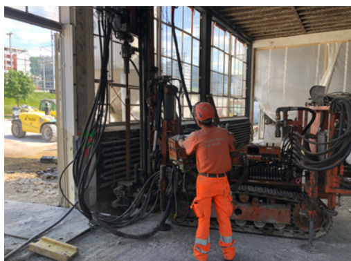
Mikropfähle 38/76 in Zug, etwa 500 Laufmeter
