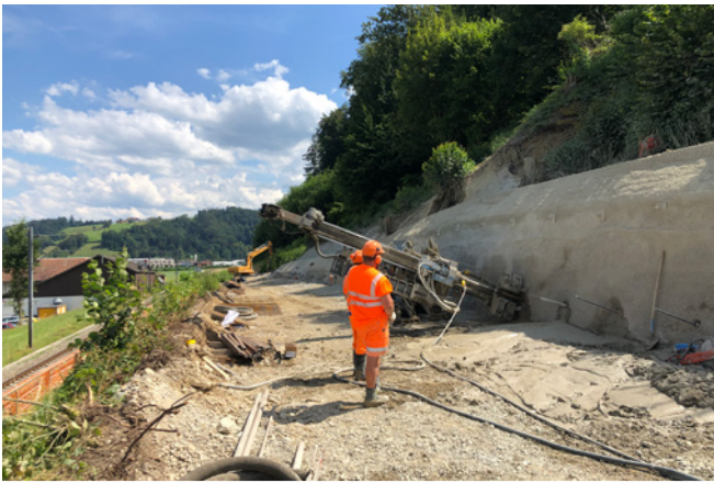
Nagelwand 32/60 in Gettnau (BLS), etwa 1000 Laufmeter
