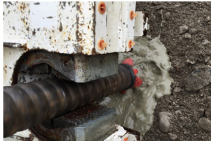
2. KÜMIX® mittels Spülkopf durch das KÜPS® aus der Bohrkronen pumpen. Bohren während laufender KÜMIX® -Spülung.
