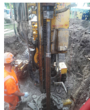
Mikropfähle 38/76 in Teufen, etwa 350 Laufmeter
