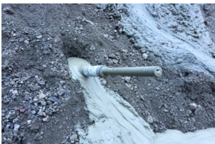
7. Komplet verpresstes und eingebettetes KÜPS® -System.
