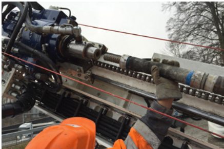
1. KÜPS® ankoppeln am Bohrhammer.
