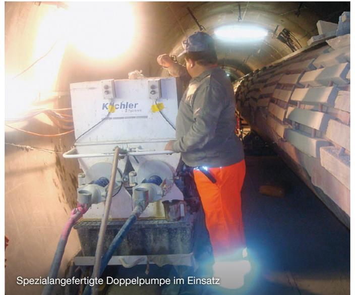
Spezialangefertigte Doppelpumpe im Einsatz
