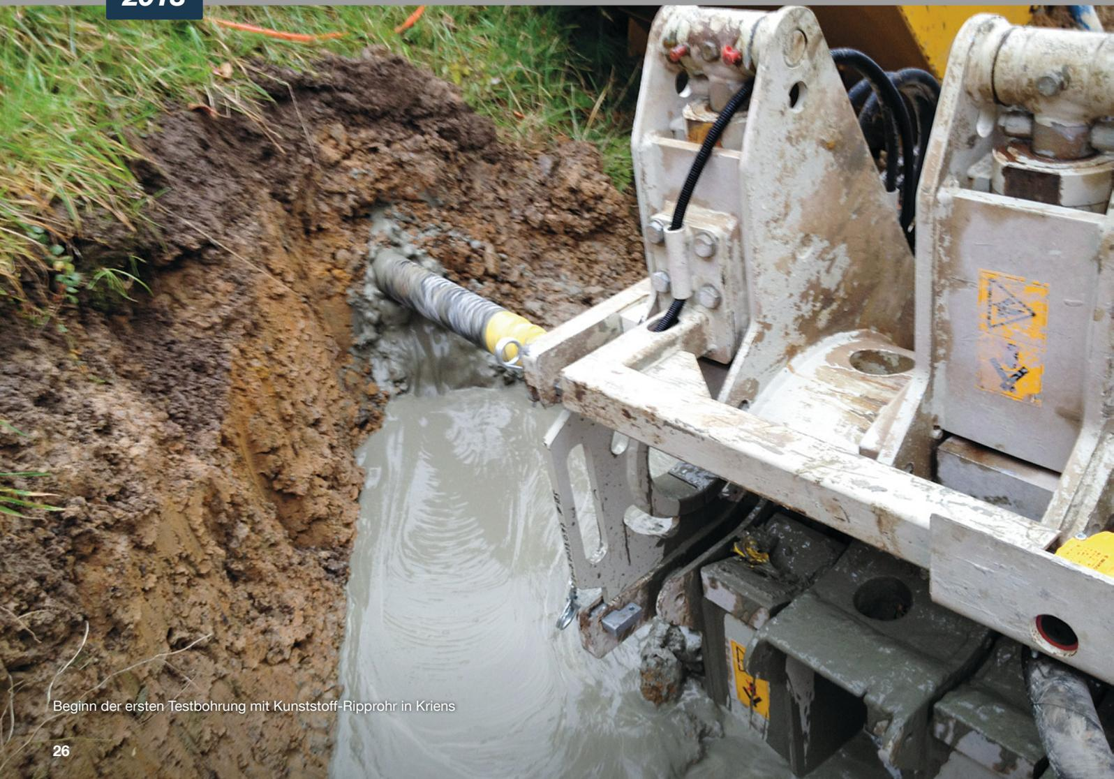
Beginn der ersten Testbohrung mit Kunststoff-Ripprohr in Kriens
